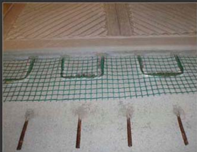
Ejemplo de instalación de red calefactora en rampas de acceso a garaje.
