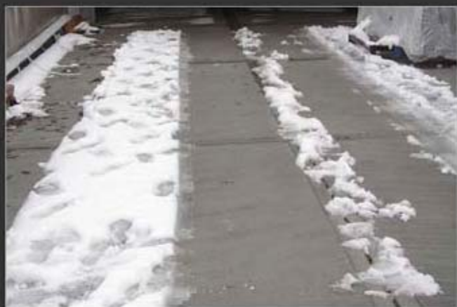
Ejemplo de instalación de red calefactora en rampas de acceso a garaje.
